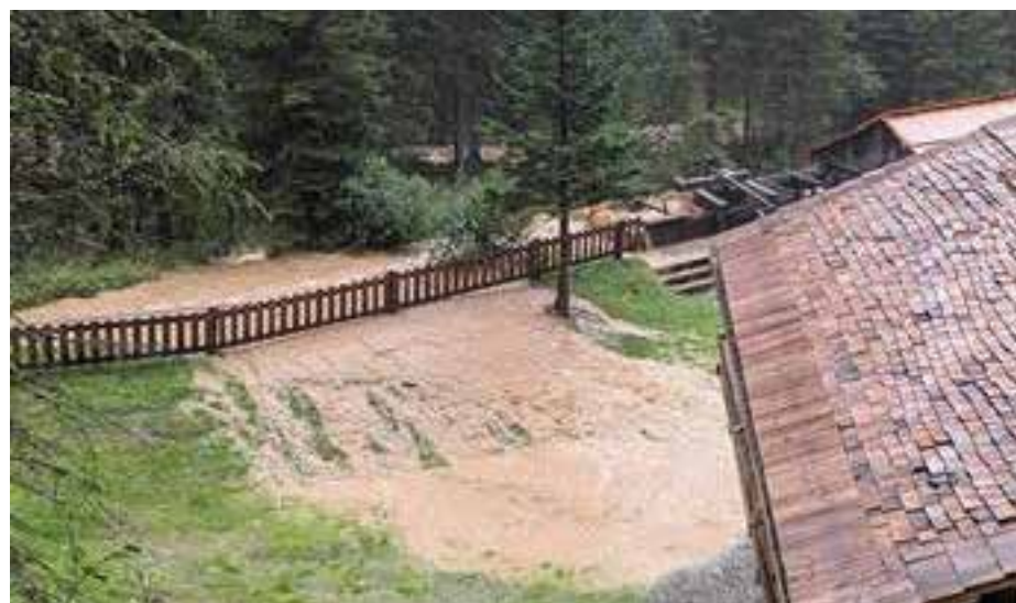
Vermurung im Bereich oberhalb der Säge nach einem Unwetter im August 2024
