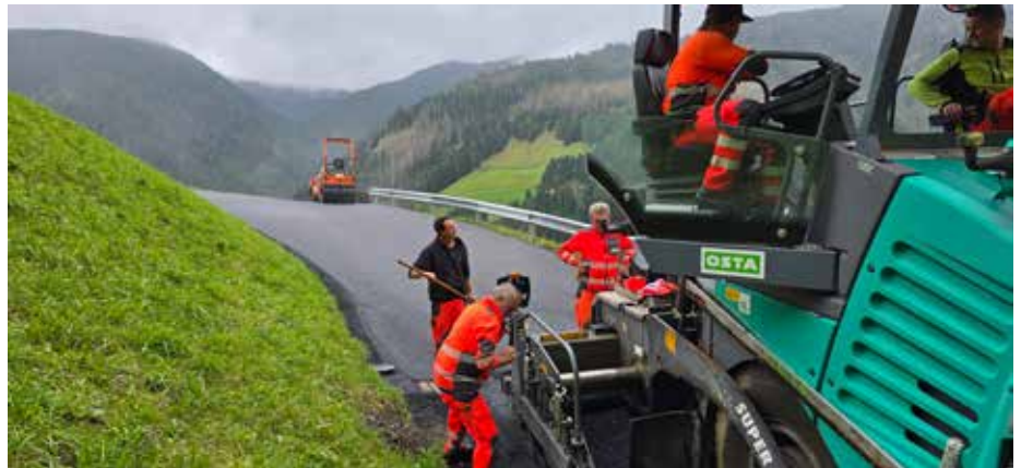
Asphaltierungsarbeiten Höggerweg
