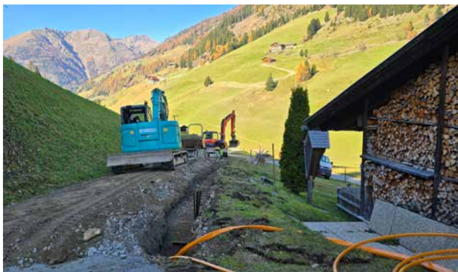
LWL-Ausbau im Bereich Hetzwald
